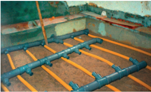
Einbau eines Drainagesystems unterhalb des Fundamentes (hier in der Bauphase) mit dem Ziel, die radonhaltige Bodenluft abzusaugen und nach draußen zu befördern
